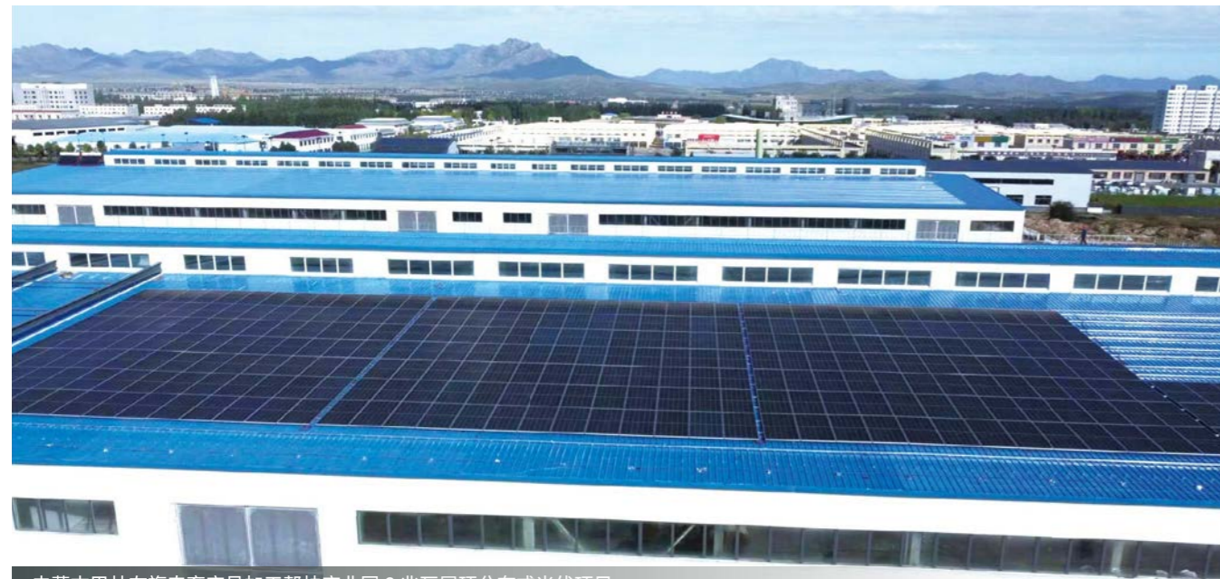
内蒙古巴林左旗农畜产品加工帮扶产业园3兆瓦屋顶分布式光伏项目
