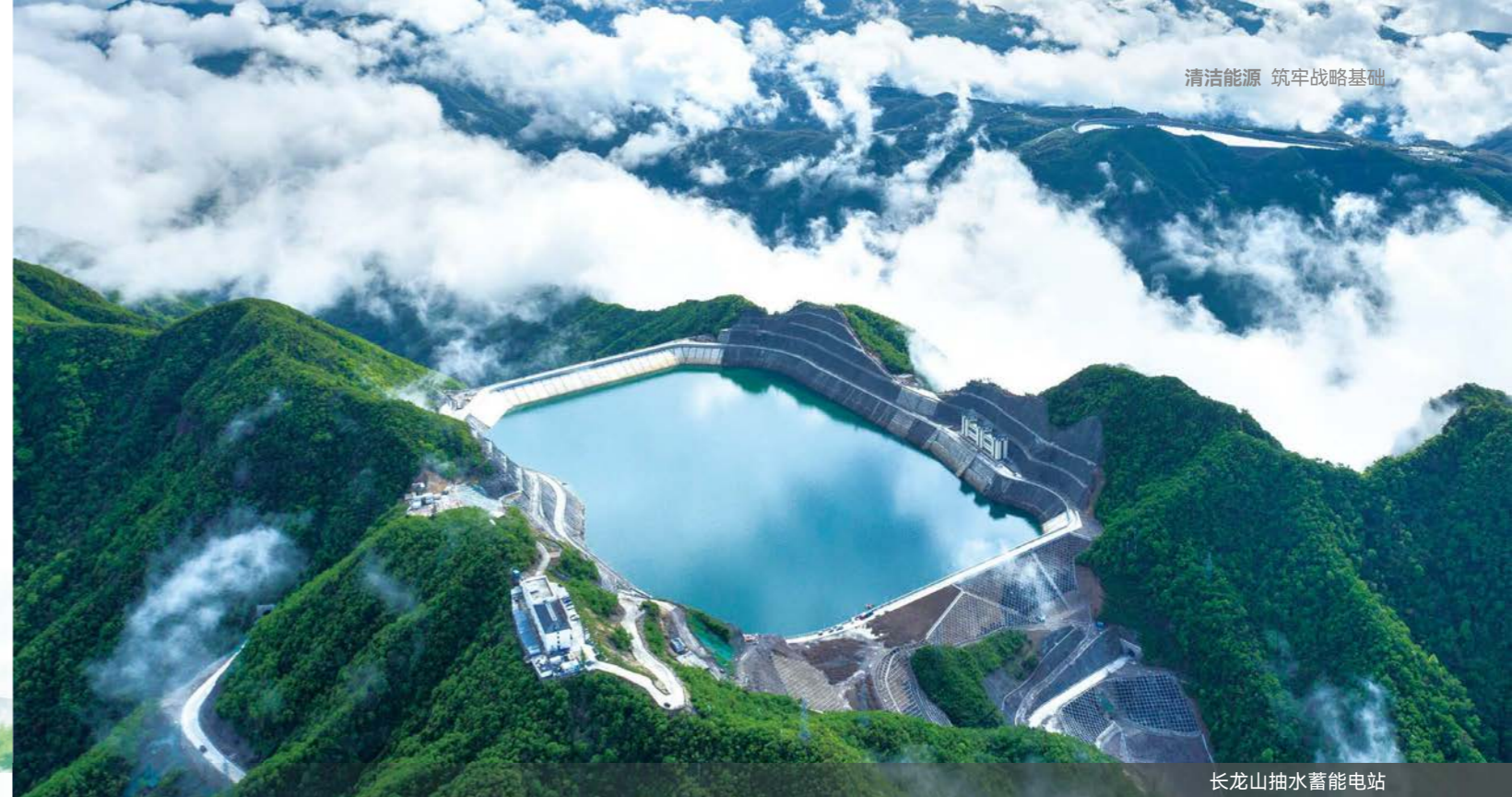
长龙山抽水蓄能电站
